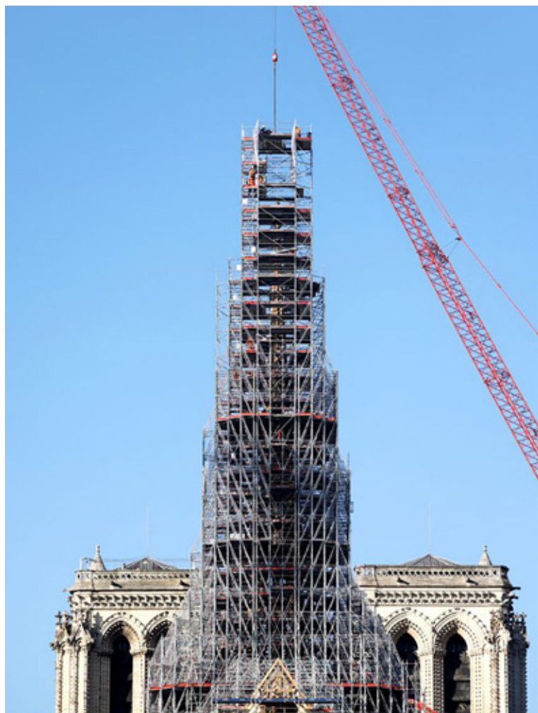
Steigerwerk om de nieuwe torenspits van de Notre-Dame te installeren. Foto: Ludovic Marin/AFP via Getty Images.
